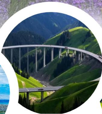
สะพานกัวจื่อโก
